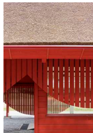
Exempel på spalje i glespanel med rundad form. Eriksberg, Sandell Sandberg.
