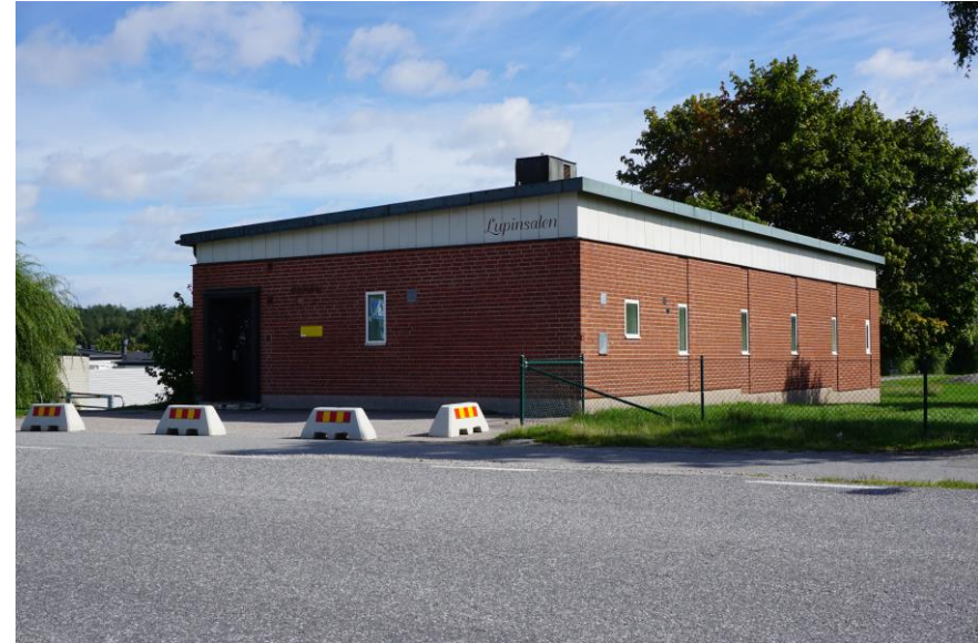
Televerkets byggnad som blev en samlingsal.
