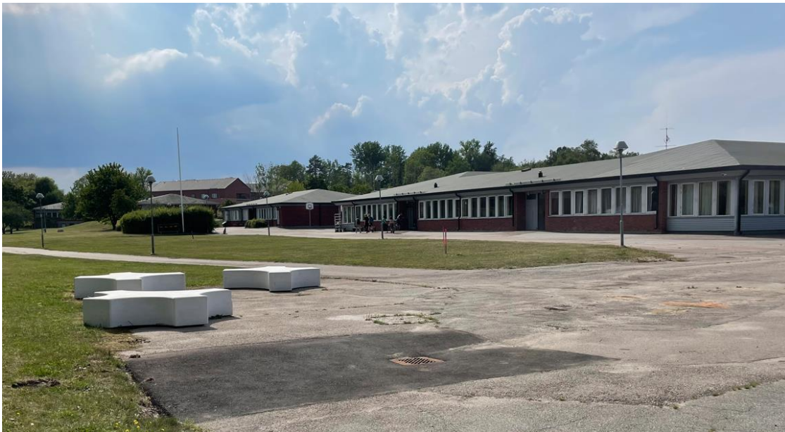
Uppgårdsskolan sedd från nordöst. På bilden framgår tydligt byggnadens karaktärsfulla fönsterband och valmade tak. I förgrunden syns parkstråket som leder mot centrum.
