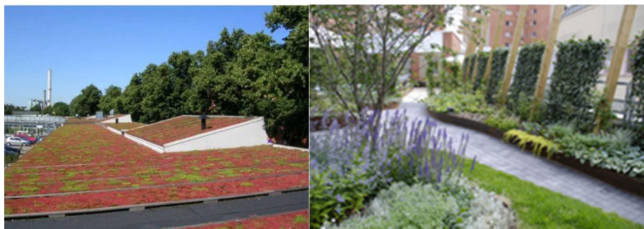
Figur 9 Gröna tak med olika karaktär och fördröjningsförmåga
